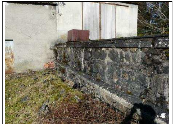
Vue de la cuve et de l'atelier accolé
