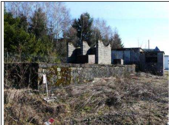
Vue de la cuve et des berceaux de l'ancienne cuve de stockage
