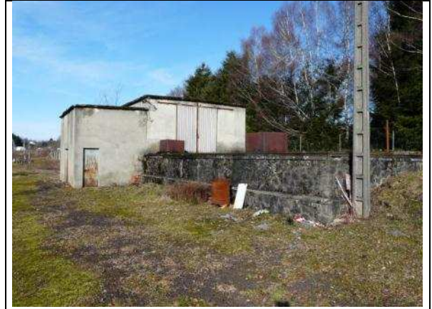
Vue de la cuve et de l'ancien atelier et chaufferie
